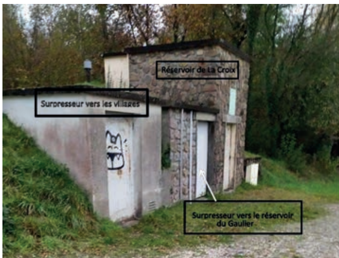
Réservoir et surpresseurs de La Croix.
